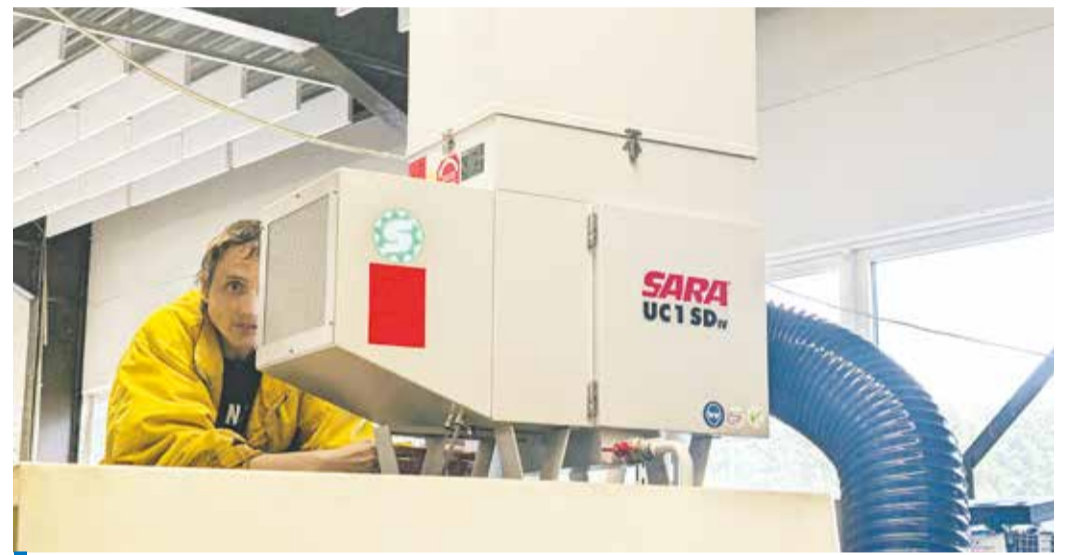
Manfred L. bei der Montage der neuen Absauganlage – ein Einsatz für saubere Luft und bessere Arbeitsbedingungen in der Schlosserei.
